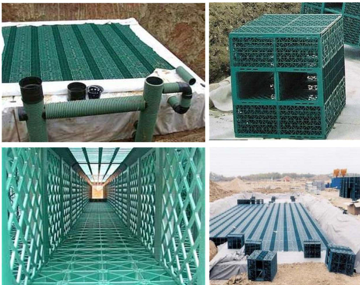
**Figura 15.** Strutture reticolari per lo smaltimento delle acque meteoriche per infiltrazione nel terreno.
