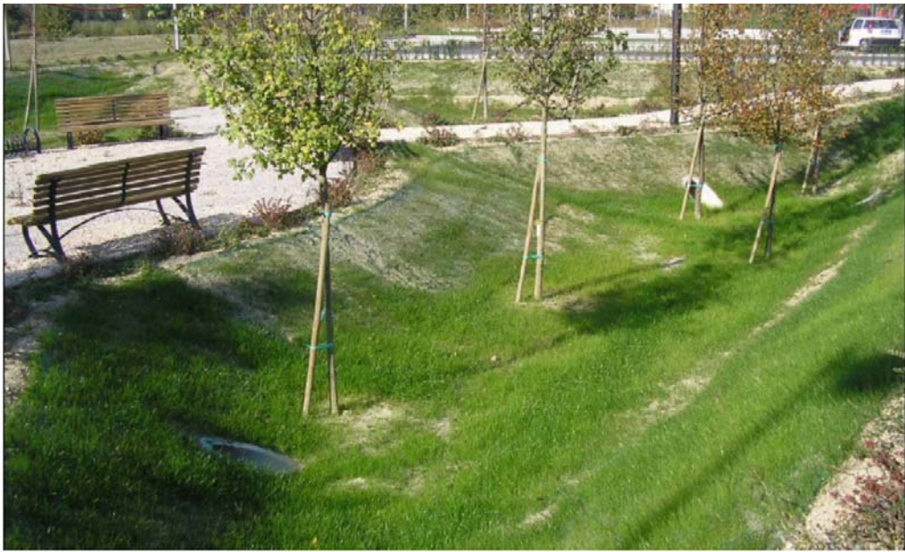
Figura 62: esempio di bacino di laminazione inserito in un'area a verde in Provincia di Verona
