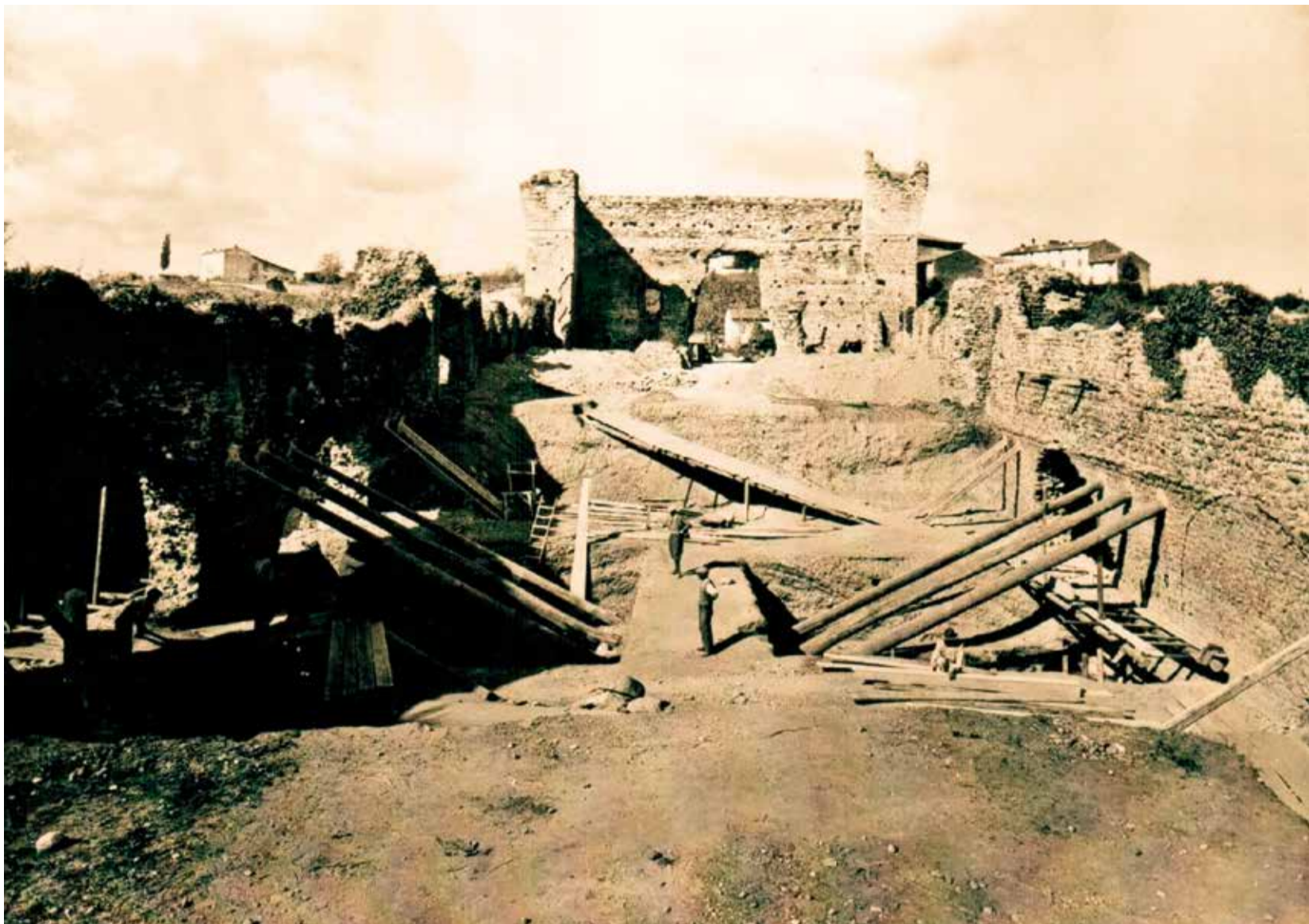
Lavori per il sottopasso al Ponte Visconteo -1931/2
